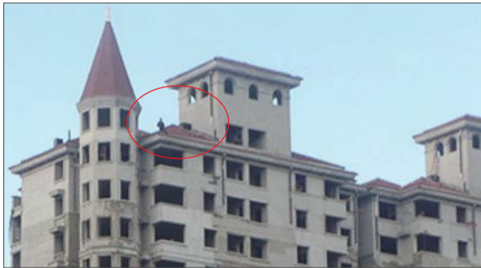
农民工情绪激动,在18楼楼顶欲跳楼。通讯员供图
