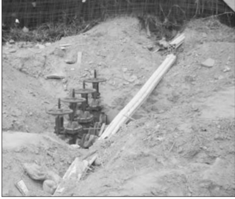
由于刚完成施工,水木清华小区内的一处供暖管道周围还是新土。本报记者孟凡萧摄
