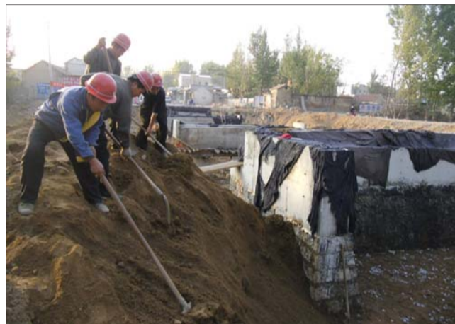
北师中桥桥墩桥台已经建好。本报通讯员 王瑞 摄
