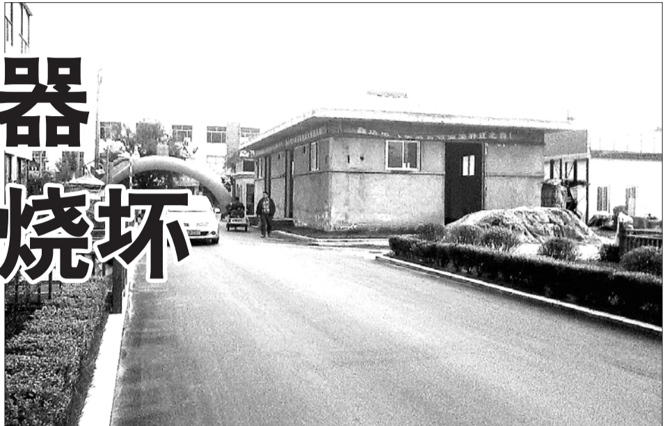
▲配电室早已建好,但里面空荡荡的。路帅 摄
