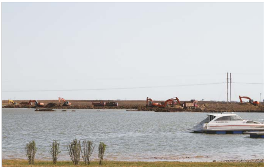
“金湖银河”工程施工现场。
