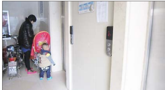
“罢工”电梯已恢复正常。本报记者 孔红星 摄
