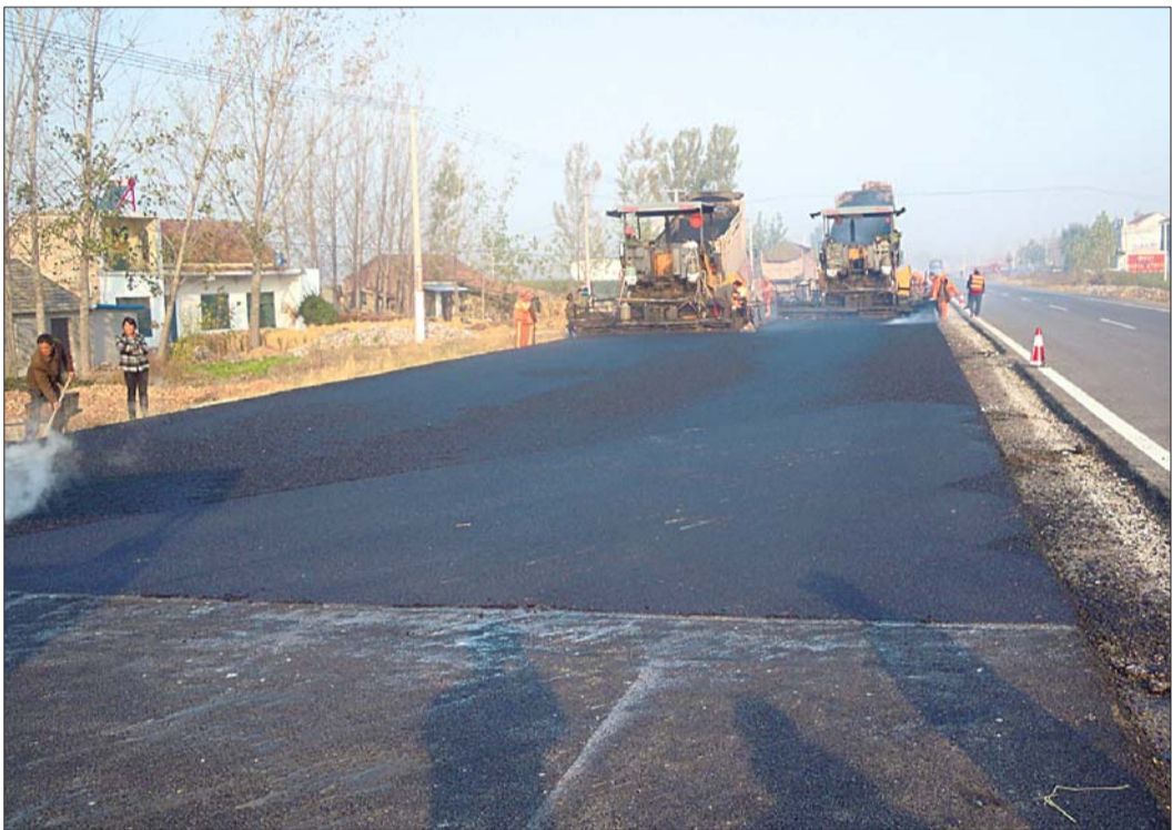
济鱼线(清河至王鲁段)正在进行路面铺设工作。
