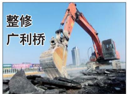
6日,黄河路广利桥上,挖掘机开始去除原来的沥青层。施工人员介绍,这次改造将对桥面和桥墩等设施进行一次系统的整修,对部分陈旧的混凝土桥面板进行更换,对受河水腐蚀的桥墩进行维护,提高荷载等级,整个工程预计2013年4月份完成。”据了解,广利桥加固施工期间,过往车辆可绕行长途汽车站北侧的辅道通行。
