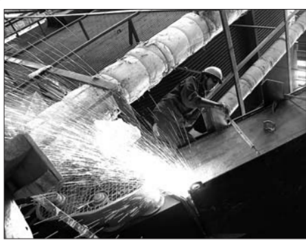
▲锅炉焊接时候,火花四溅。
