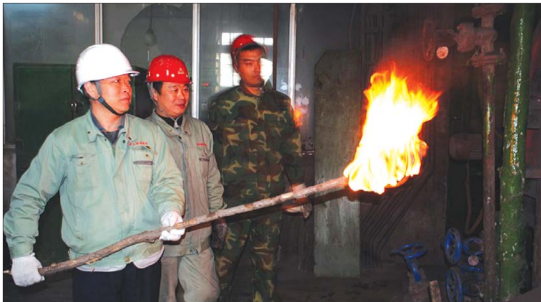
工作人员点燃锅炉。本报记者 王世腾 摄
