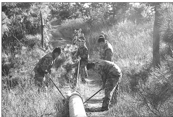
驻岛官兵和长岛供电公司的员工正在忙着抢修被破坏的电线杆。(图片由通讯员提供)
