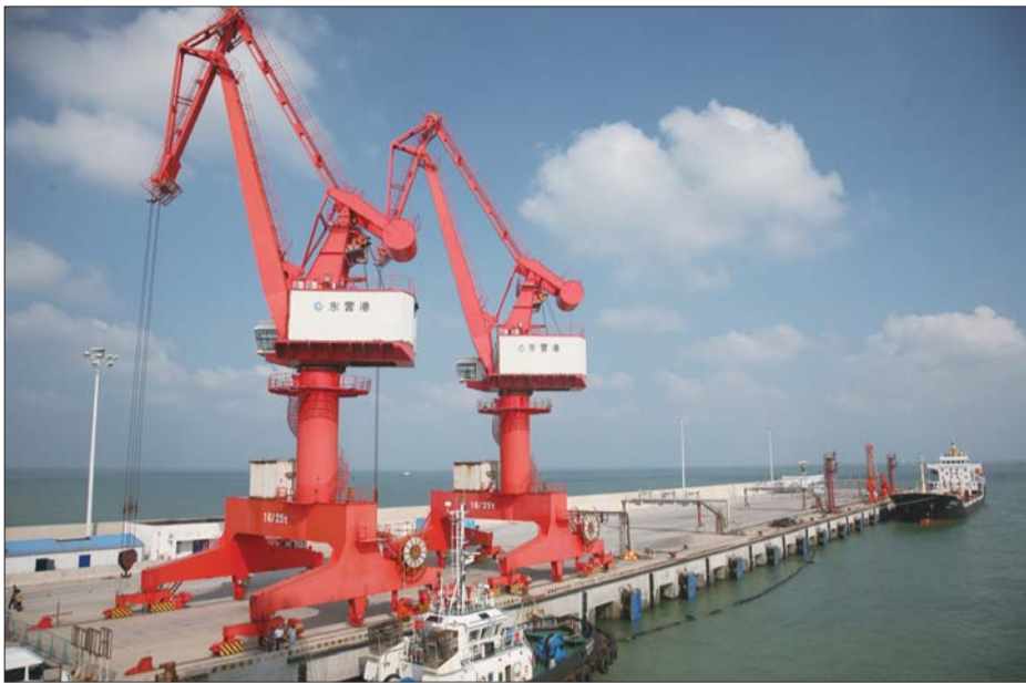
东营港3万吨级液体化工品码头。
