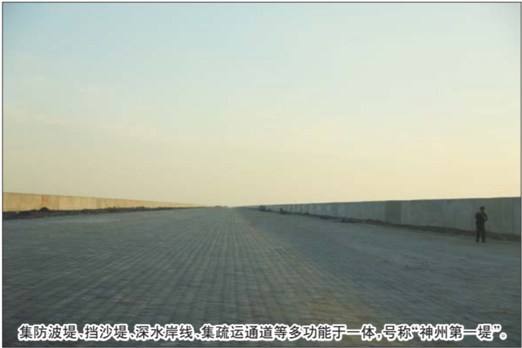
集防波堤、挡沙堤、深水岸线、集疏运通道等多功能于一体,号称“神州第一堤”。
