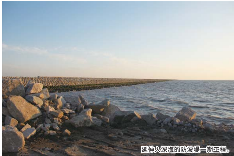
延伸入深海的防波堤一期工程。
