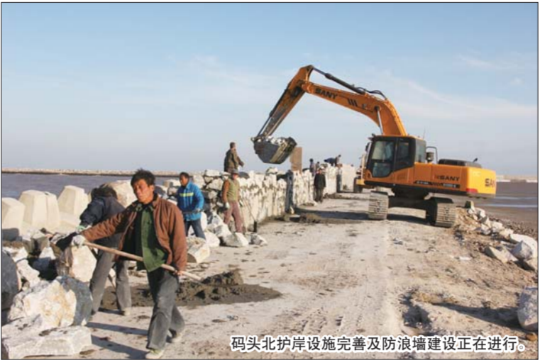
码头北护岸设施完善及防浪墙建设正在进行。
