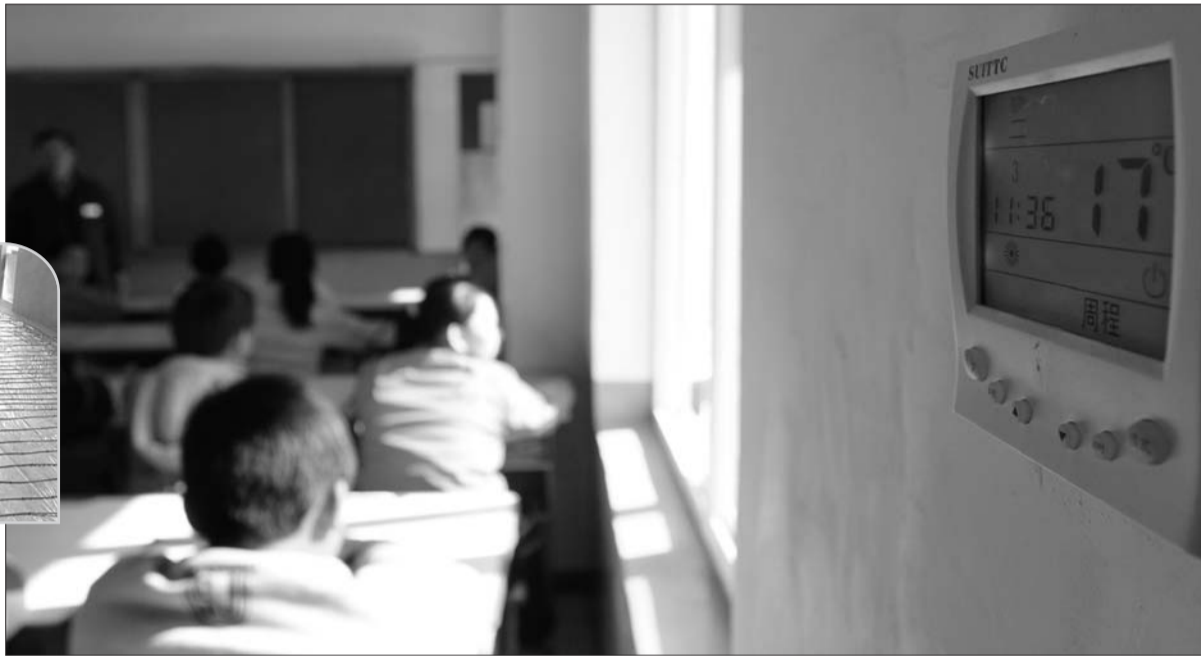
▲电热膜地暖控制器可自动调节室温。 ▶学校电热膜地暖控制器。
