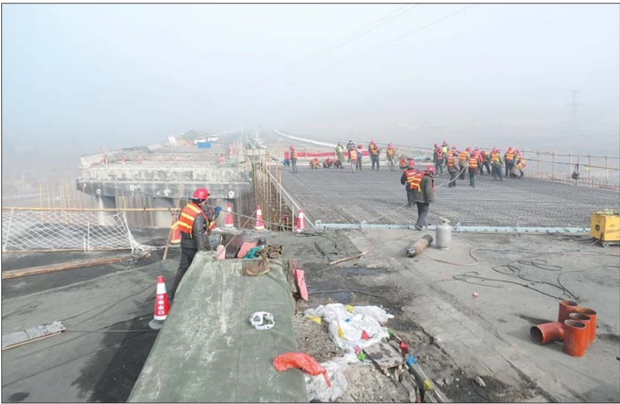
17日,在济荷高速平阴段烧毁的大桥处,一半正准备浇注水泥,另一半仍“悬空”。 本报记者 刘志浩 摄
