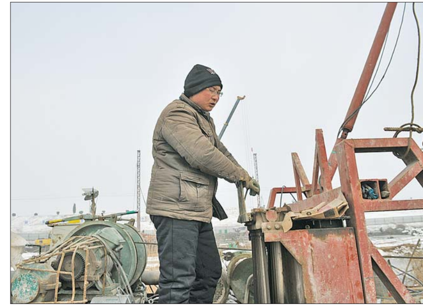
23日,南水北调工程玉清湖引水泵站工地,工人们在处理地基。 本报记者 周青先 摄
