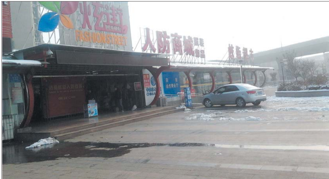
原本2011年6月开业的炫街人防商城,直到现在仍未正常营业,绝大多数店铺处于关门状态。
