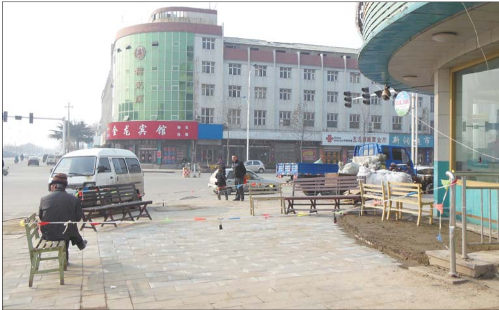
23日,塌陷区域已经维修好,周围还拦着绳子。记者 王永军 摄
