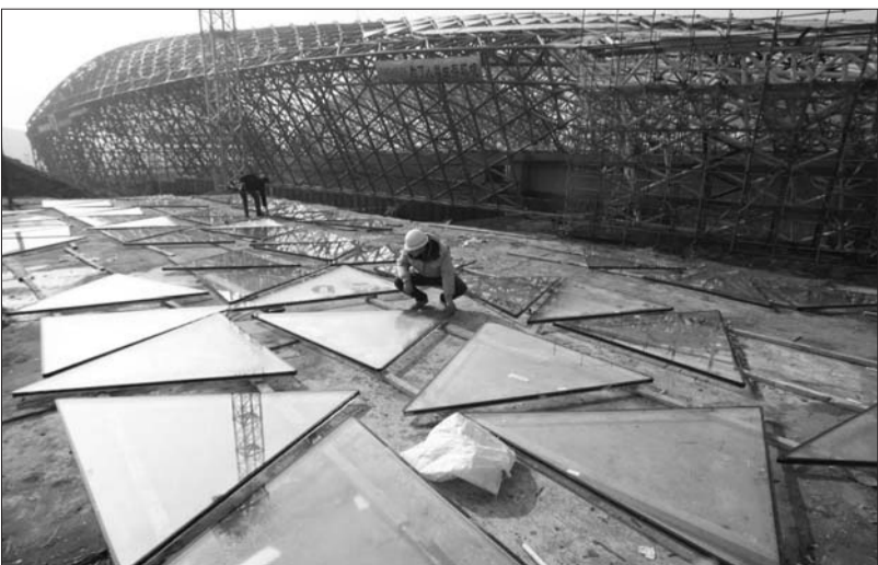
施工人员在安装外围玻璃幕墙。 本报记者 张晓鹏 实习生 高开元 摄
