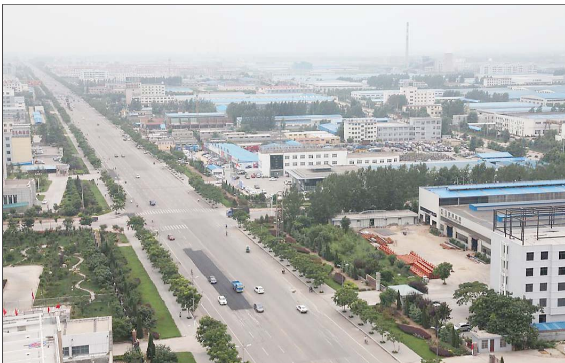
2012年完工的基础道路设施。 本报通讯员 张艳艳 摄
