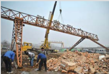
钢材经营业户正在拆除行车。
