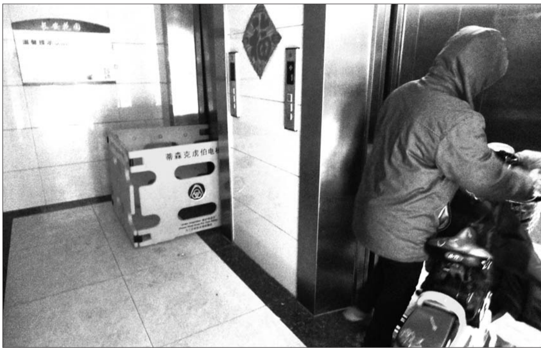
维修人员正在施工。本报见习记者 张林 摄
