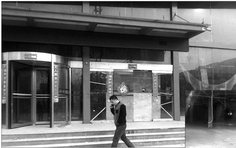
宝岛渔港酒店已关门。原本摆满桌椅的一楼就餐大厅已变得空空荡荡,天花板也已经拆除了一半。
