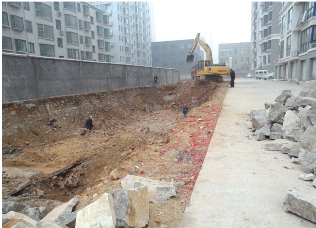
金岭家园小区南侧空地挖了约50米长的大坑。 本报见习记者 侯峰 摄
