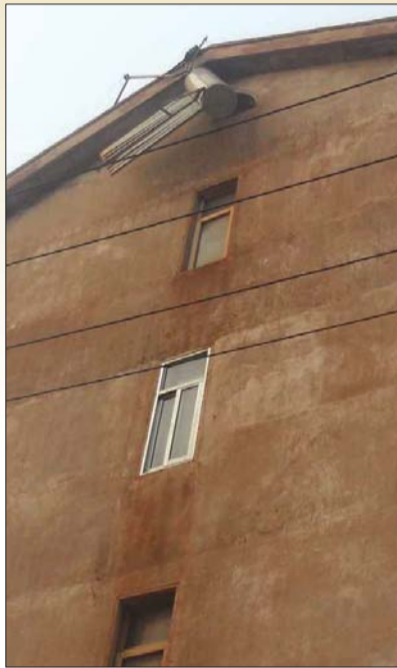
悬挂在空中的太阳能热水器。梁铁君 摄
