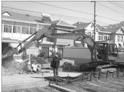
崂山路旁的一些民宅在规划的宅基地以外擅自搭建起违法建筑,23日,崂山城管依法对此进行了拆除。
