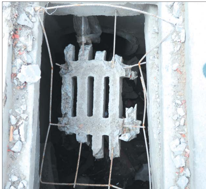
被大车连续碾轧,这个钢筋水泥的井算子只剩一小块水泥和钢筋连着。实习生 王鑫鑫 张明娟 摄
