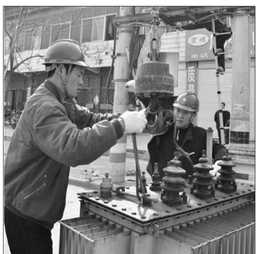
山东枣庄供电公司峄城客服中心(运检站)配电维护班施工人员,在城区东部一公变台区现场,忙着更换安装变压器。据现场施工负责人介绍,他们结合配电台区设备排查隐患,对存在的缺陷实施更换变压器或增加变压器容量,也是做好城区电网设备迎峰度夏的行动之一。
