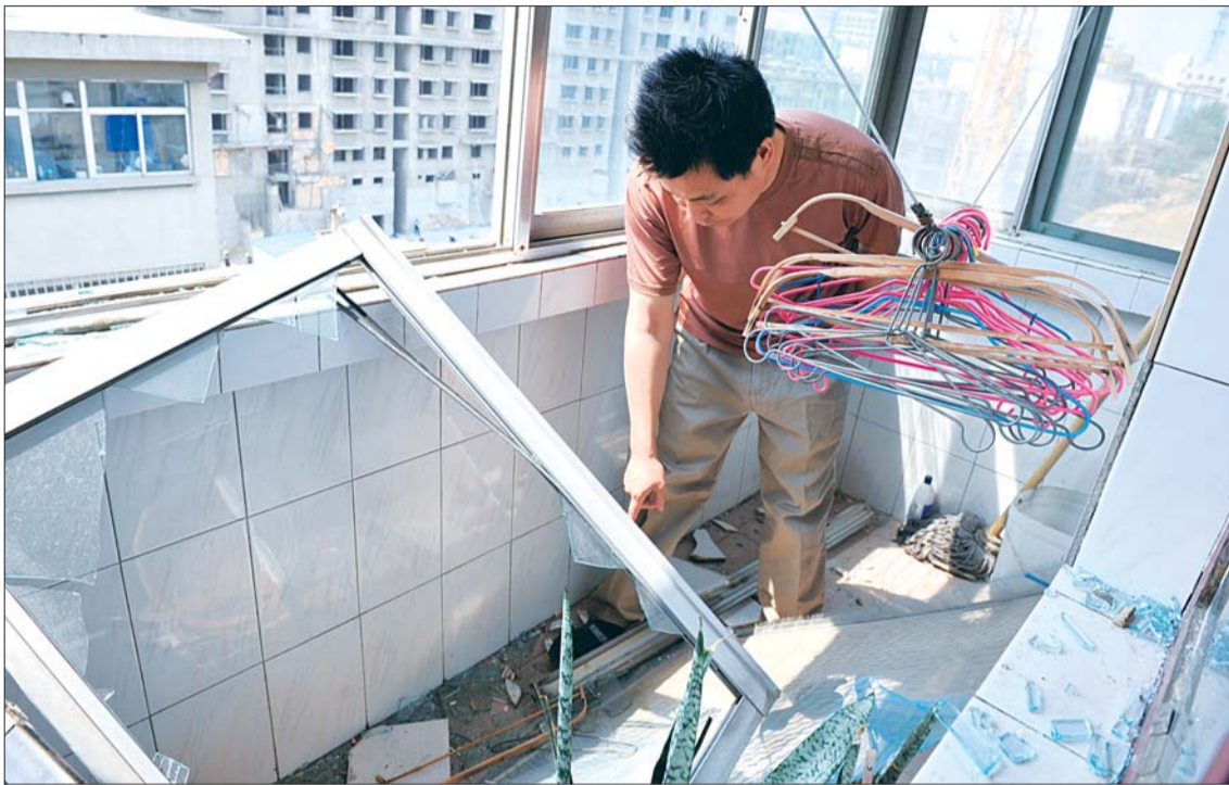
居民家阳台窗户被砸坏。本报记者张林摄
