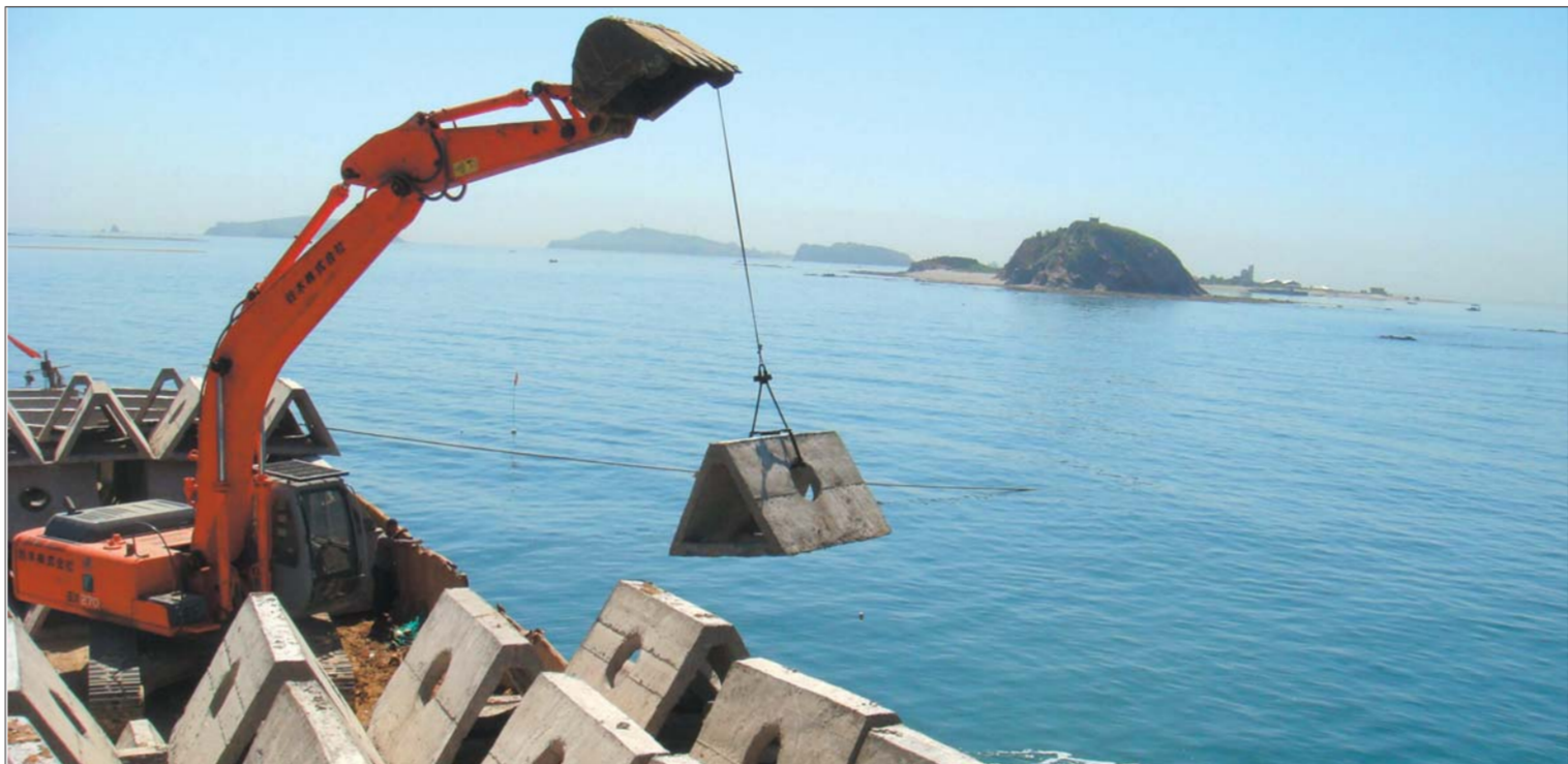
挖掘机正在投放空石,建设人工鱼礁(资料片)。
