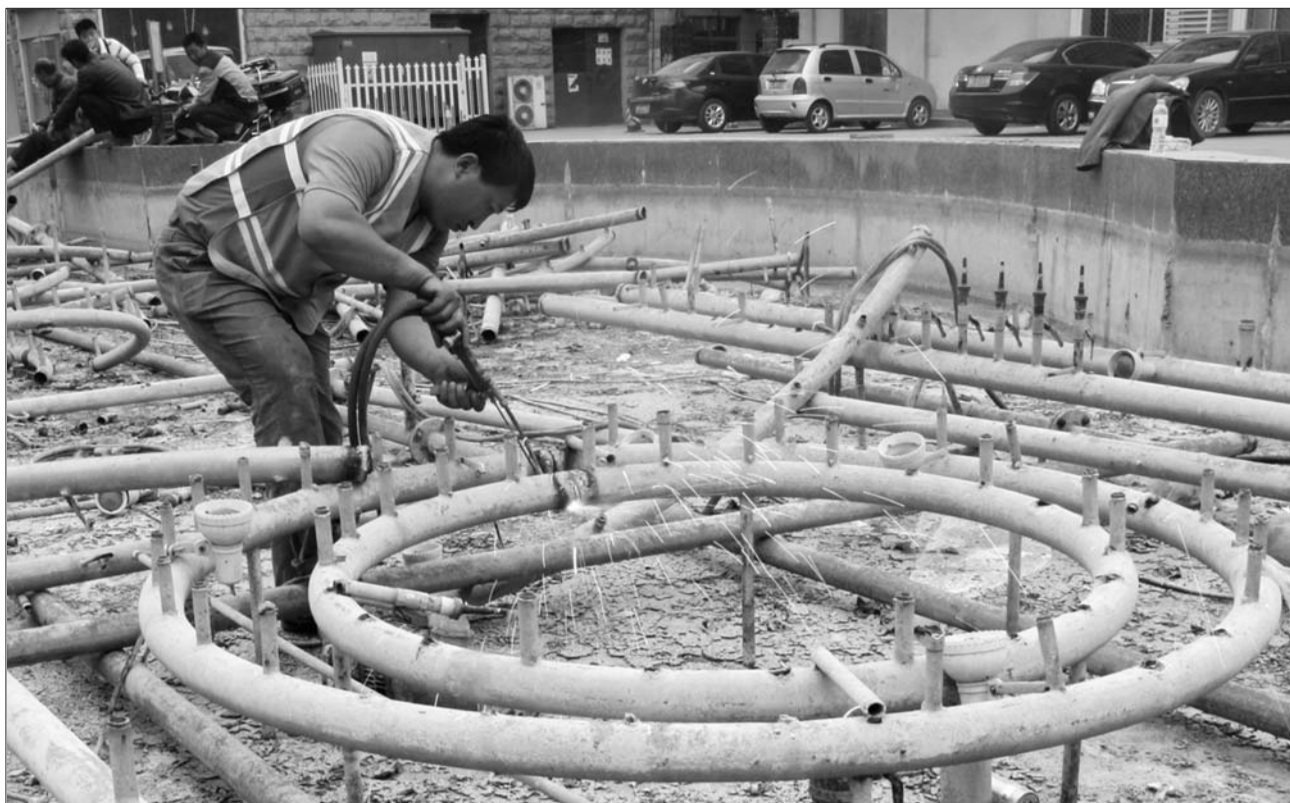
▲8日上午,张店区园林局工作人员对步行街上的喷泉设施进行拆除。 本报记者 王鑫 摄
