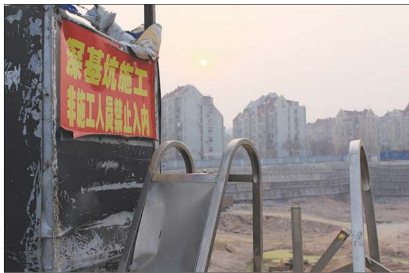
湛山广场工地的大坑开挖多年没回填。(资料片)
