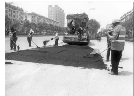
13日上午,市政处工作人员正在维修振兴路非机动车道破损处。据了解,近日市政处工作人员开始修补振兴路上的路面破损处,同时还对非机动车道进行了修补。
