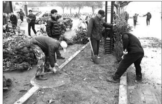
施工人员加紧施工。
