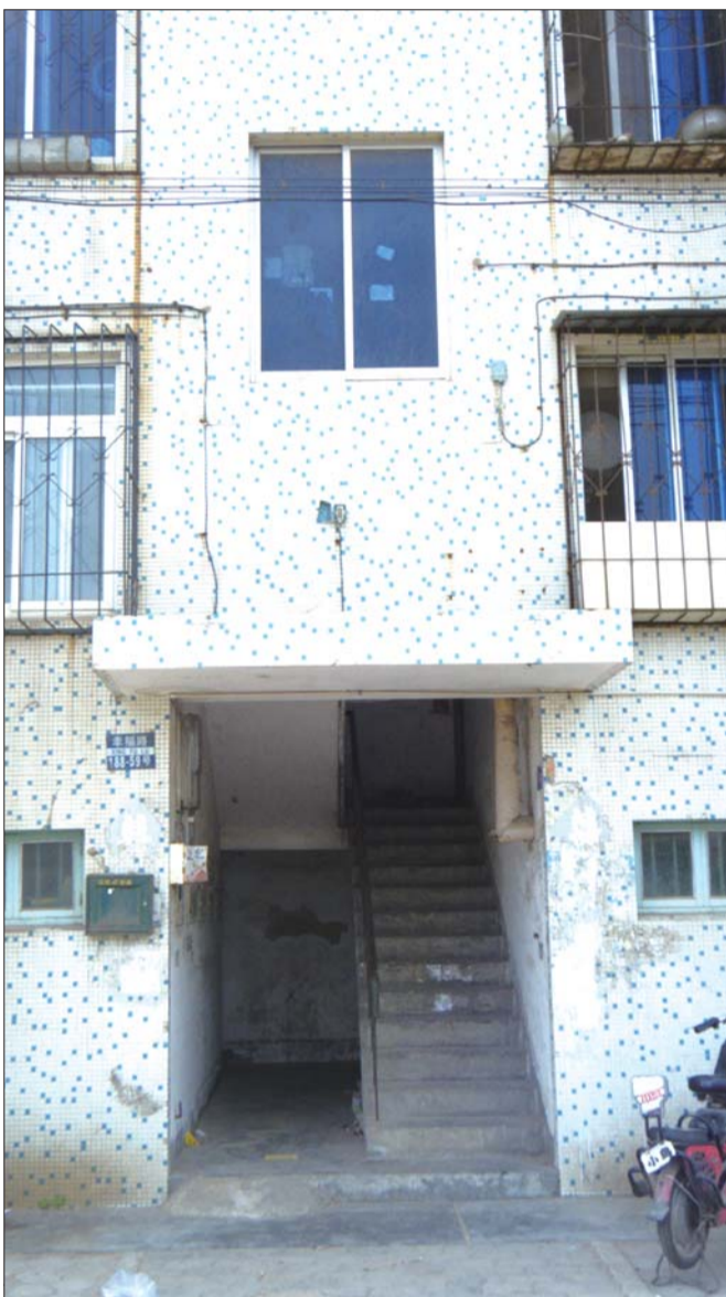
这栋居民楼地下室的一间储藏室内储存的大蒜变质,居民们以为是天然气泄漏。记者 苑菲菲 摄
