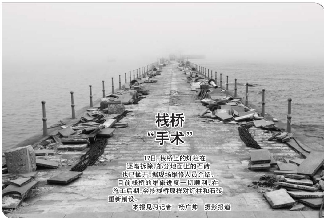
17日,栈桥上的灯柱在逐渐拆除,部分地面上的石砖也已掀开。据现场维修人员介绍,目前栈桥的维修进度一切顺利,在施工后期,会按栈桥原样对灯柱和石砖重新铺设。
