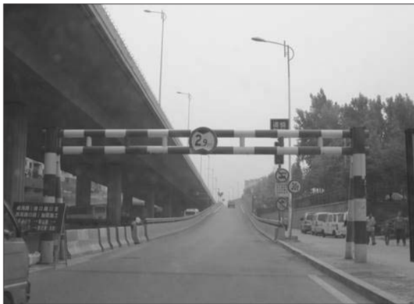
杭鞍快速路山东路东向西上桥口设置的限高杆。(图片由交警部门提供)
