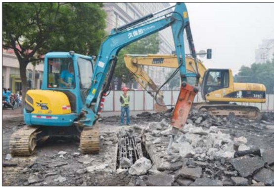
在羊头峪西沟桥,施工人员正在开挖路面查看管线情况。 本报记者 王光营 摄
