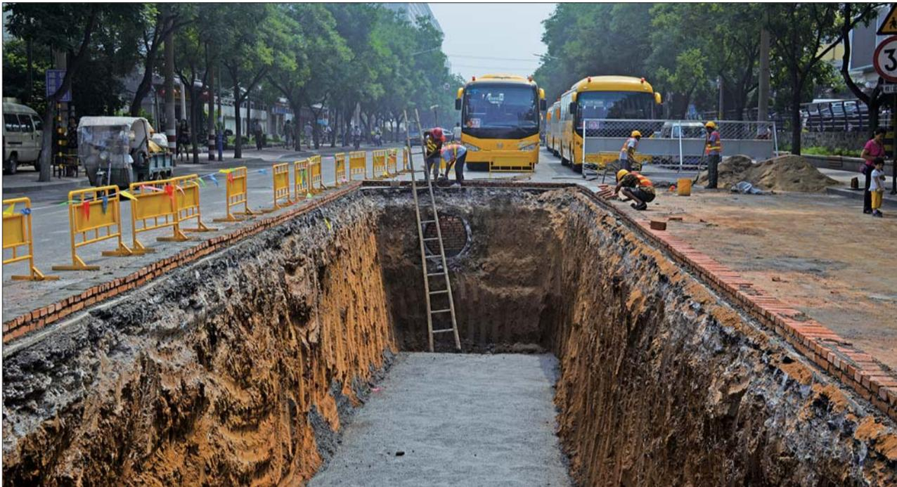
和平路改造路面已经开挖,将建设电力沟,铺设供暖管道。
