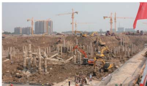
红星美凯龙家居MALL基础工程
