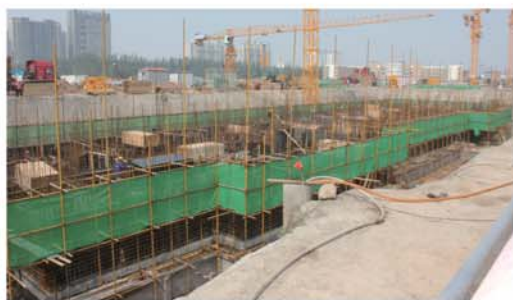
住宅4号楼基础工程
