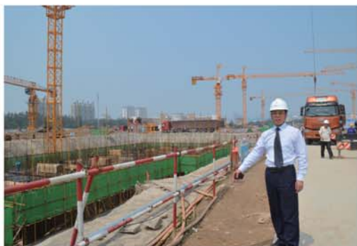
星凯地产副总段春华亲临施工现场讲解
