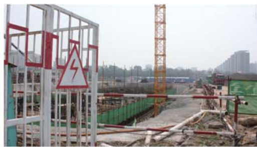
住宅4号楼基础工程
