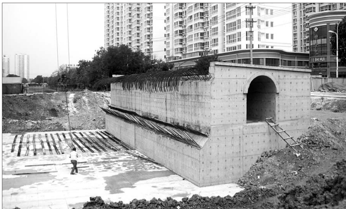
越河桥开始建设主拱,本报记者 王洪磊 摄
