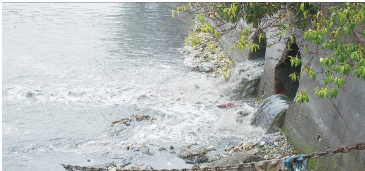
大雨过后,排水口排出大量的“污水”。 记者 王晏坤 摄
