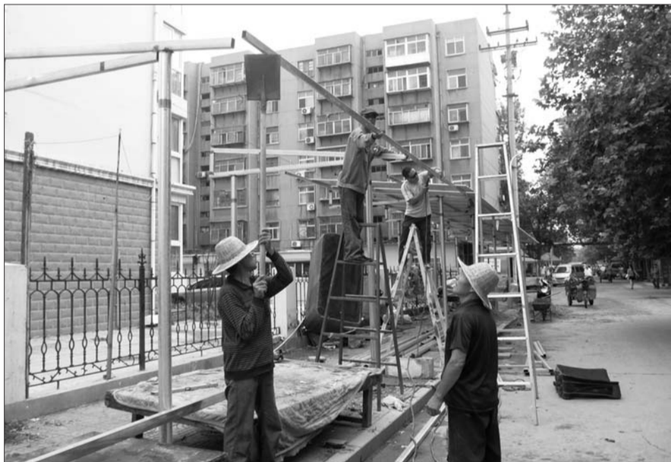
▲体育场街道办事处附近的便民市场正在进行整改施工。 本报见习记者 王欣 罗旭军 摄
