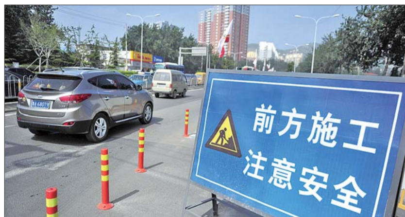
在二环南路上,施工警示牌竖在马路上。 本报记者 王媛 摄
