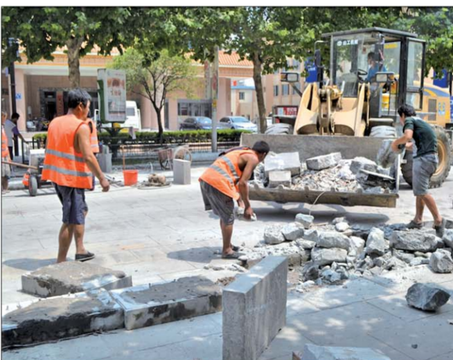
在泉城路上,施工人员在紧张施工。 本报记者 赵伟 摄
