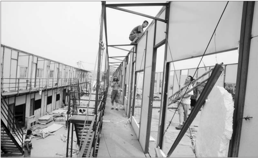
工人正在拆除存在消防隐患的简易板房。本报记者 马志勇 摄
