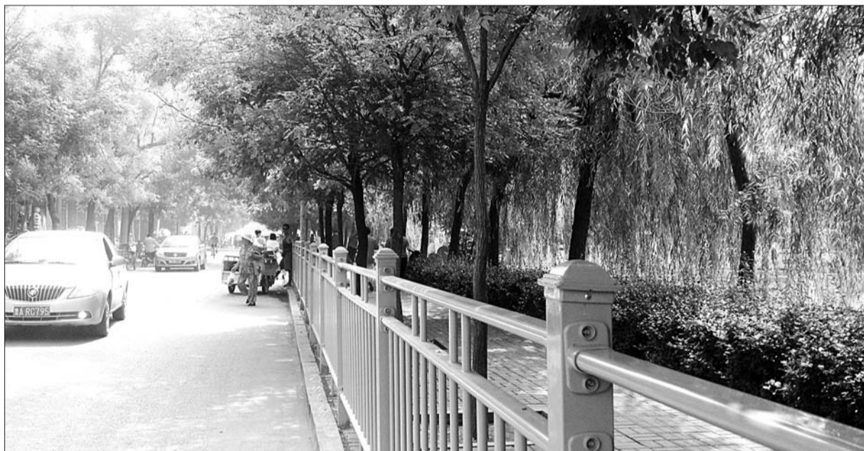
防护栏安装后, 越河北街实现了人车分流。王洪磊摄
