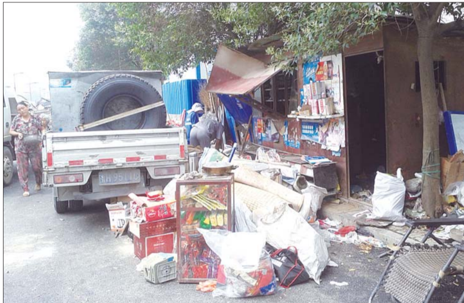
建在人行路上的铁皮屋正在拆除。本报记者 范少伟 摄
