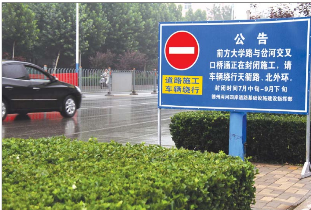
7月15日,大学路岔河桥竖起施工封闭的公告。 本报记者 王小会 摄
