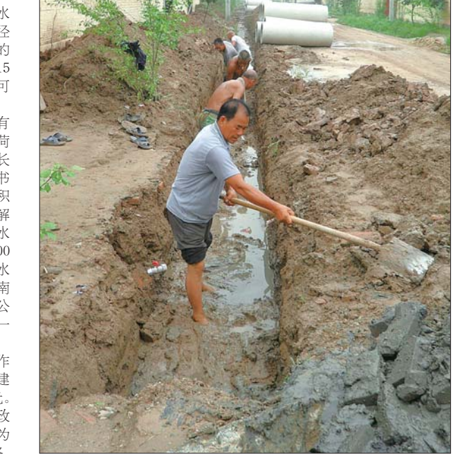
大罗庄行政村下水道施工现场。本报记者 张建丽 摄
