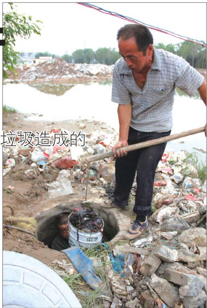
►滨城区市政工程管理处工作人员正在清理下水道。 本报记者 王晓霜 摄
