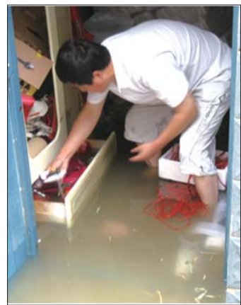
麒麟阁小区32号楼楼道内的积水严重。 本报记者 王泽云 摄
